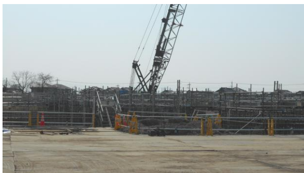
西小保方町で建設が進む新学校給食調理場
